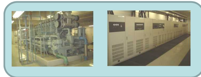
非常用発電設備、無停電電源設備等の予備電源設備
