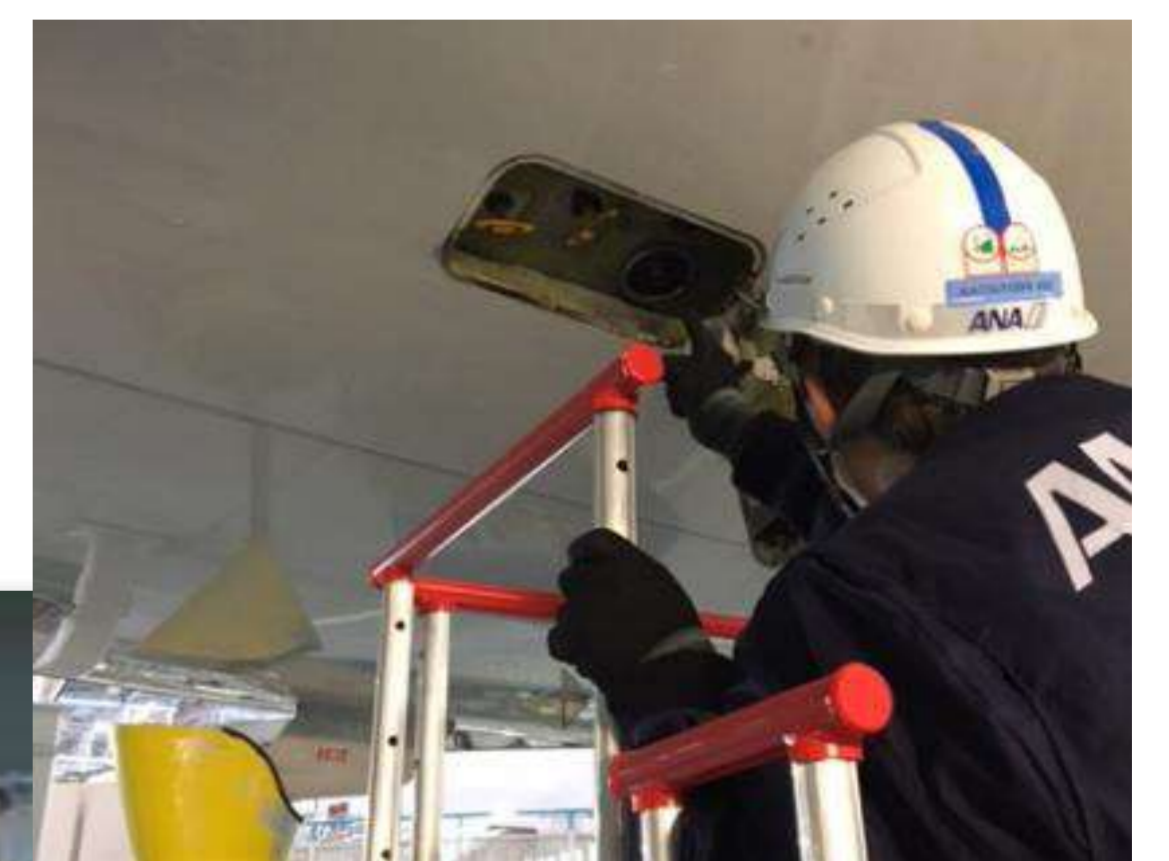
給水口の点検
