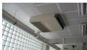
空調機（エアコン）の設置
