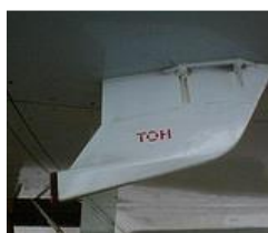
給水口の点検
