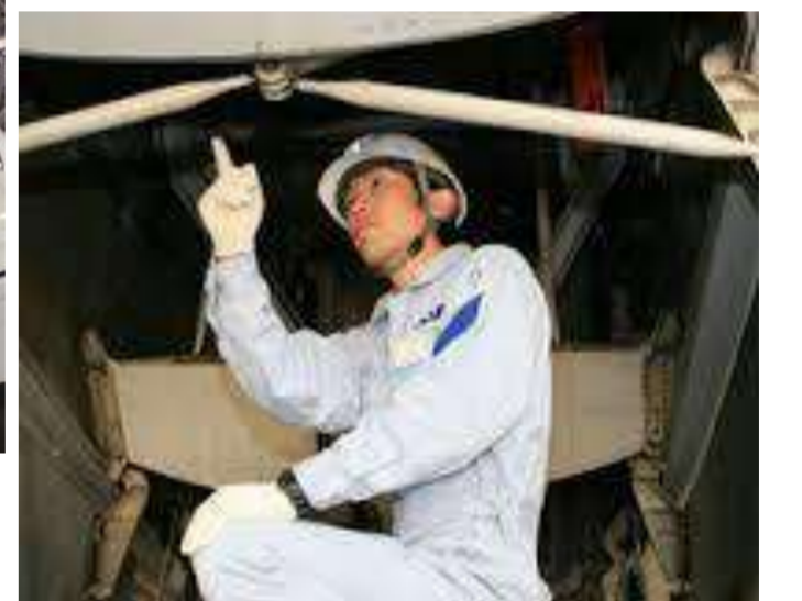
【ソフト面の対策例】 整備・点検の実施
