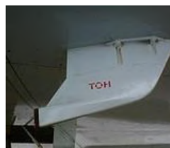
給水口の点検
