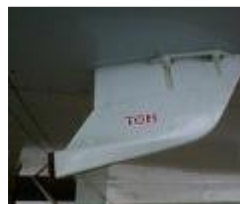
給水口の点検
