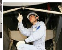
【ソフト面の対策例】 整備・点検の実施
