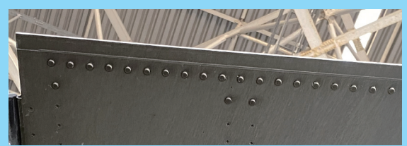
外板を接着からボルト等による取付に変更
