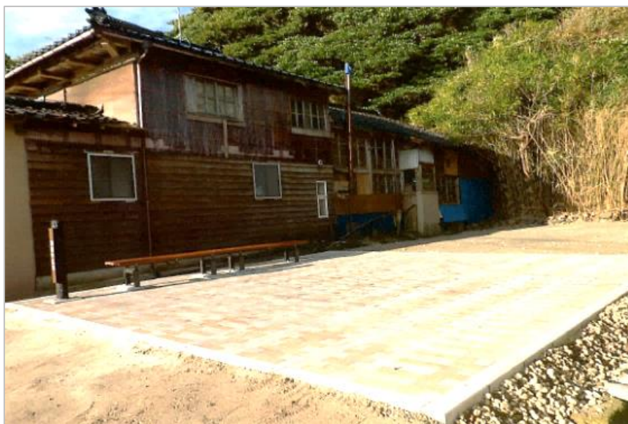
住宅火災の延焼を防ぐために整備した防火空地「ポケットパーク」
