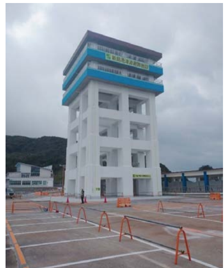
新島港津波避難施設
