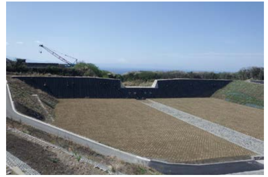
砂防施設(大島町)
