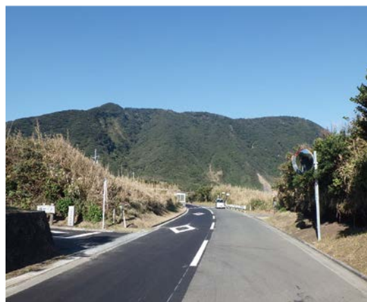
無電柱化(大島波浮港)
