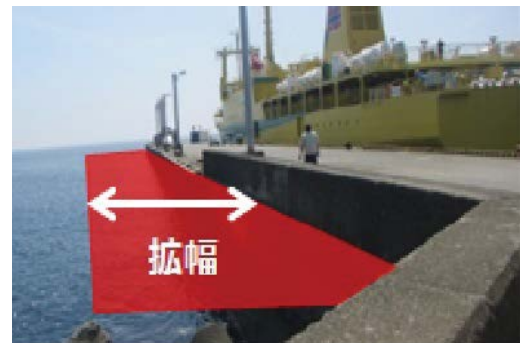
阿古漁港緊急輸送用岸壁
