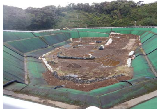
管理型最終処分場(八丈町)
