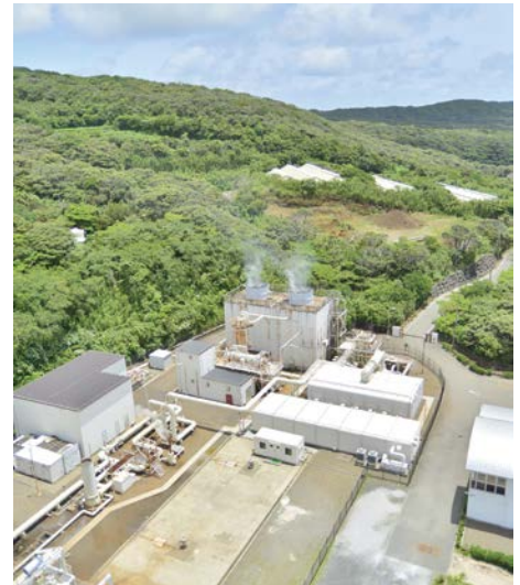
旧八丈地熱発電所
