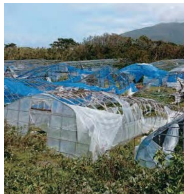
令和元年台風15号の 被害状況(新島村)
