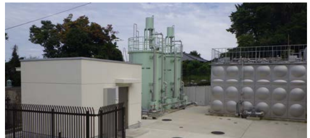
浄水場の更新事例(大島)
