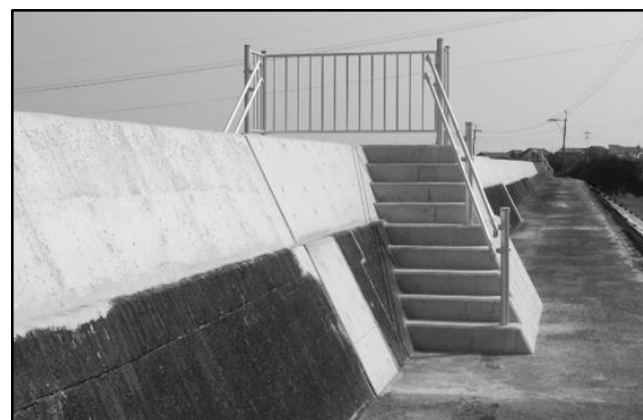
陸閘を廃止し通行用の階段を設置（中津港海岸）
