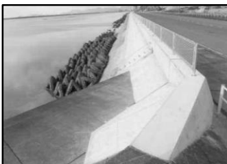
護岸の嵩上げ・補強事例
