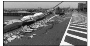
横浜港南本牧はま道路への船舶衝突 (令和元年台風第15号)
