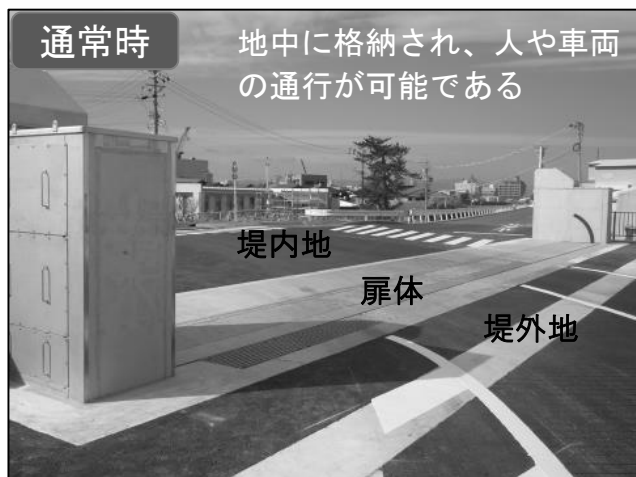
「津波等による浮力で閉鎖」するフラップゲート式の陸閘（津松阪港海岸）
