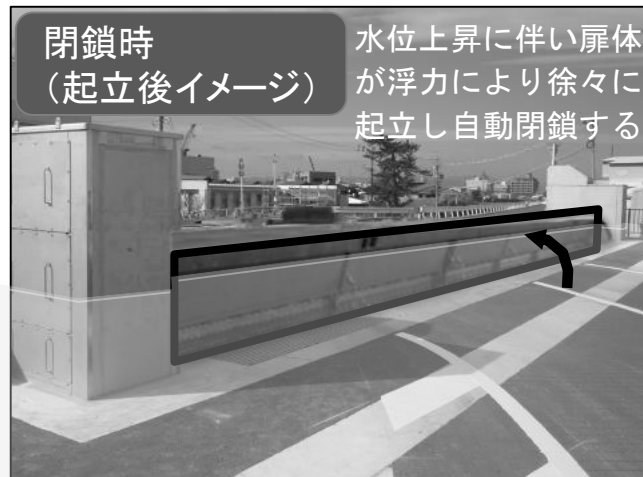
「津波等による浮力で閉鎖」するフラップゲート式の陸閘（津松阪港海岸）
