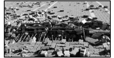
川崎港コンテナターミナルの棧橋被災 (令和元年台風第19号)
