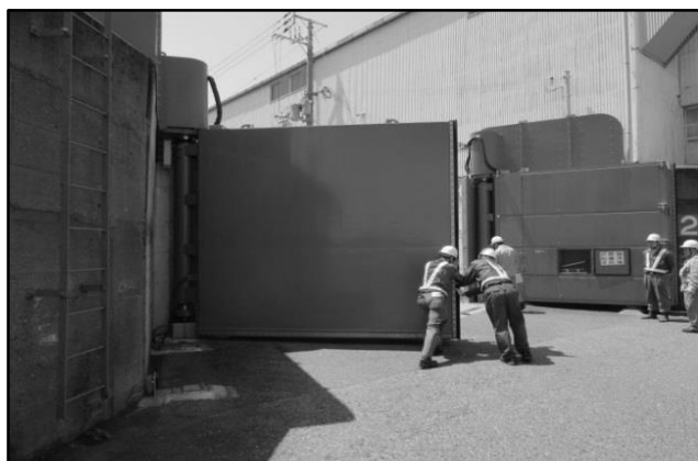
平常時の点検・訓練（大阪港海岸）
