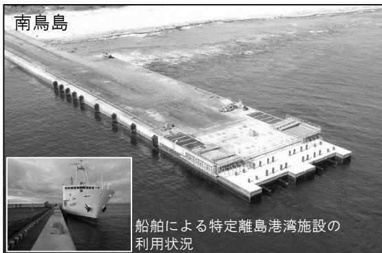
特定離島港湾施設の整備状況
