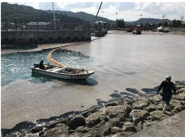
参考写真②-1: 船外機船によるオイルフェンス等の運搬
