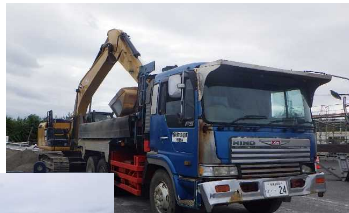
ダンプトラックへ積み込み
