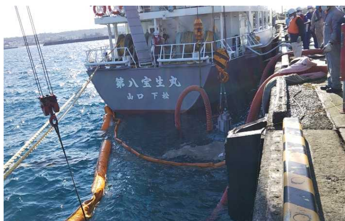
参考写真③: サンドポンプによる軽石除去状況
