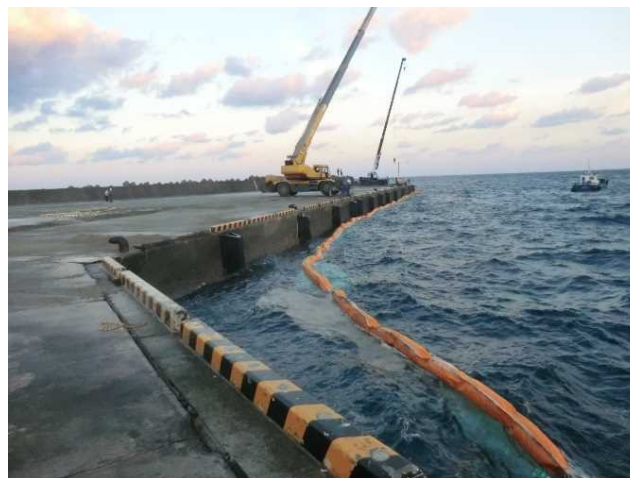
ラフタークレーンによる汚濁防止膜設置状況
