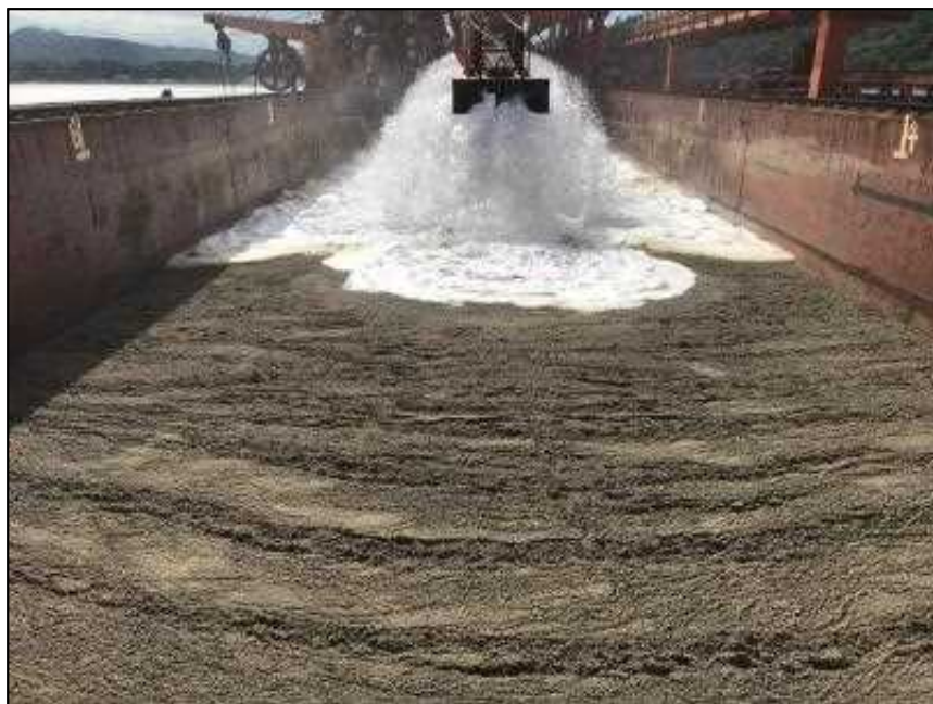
参考写真②：ホールド内への軽石及び海水注水状況
