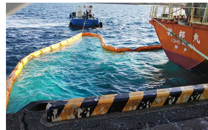
参考写真④: 汚濁防止膜の間隔保持(船尾付近)
