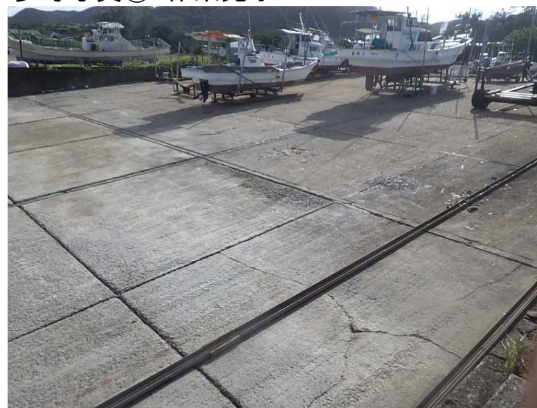
参考写真③: 作業完了
