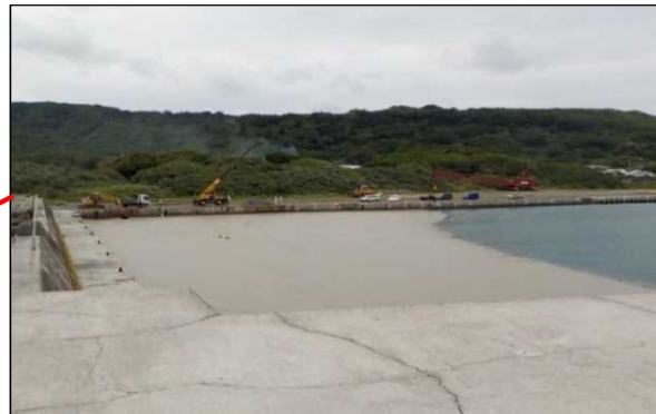
除去作業前(R3.10.19)
