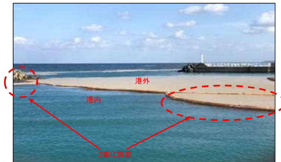
参考写真①-2: 港口における侵入防止対策
