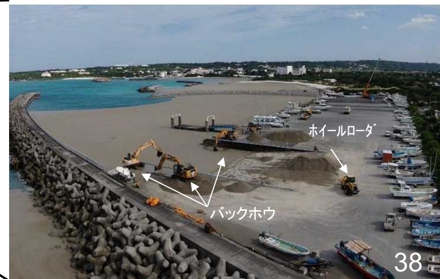
撤去状況(11月5日撮影)
