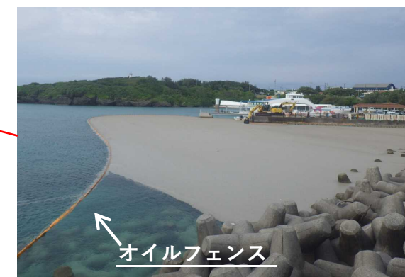
オイルフェンス設置 軽石集約状況(港内)
