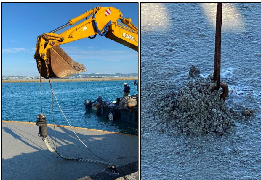
参考写真②: サンドポンプ操作・作動状況
