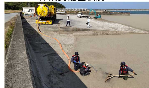
作業員配置状況
