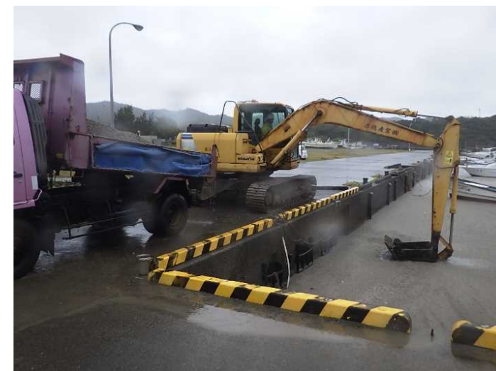
参考写真②: 4tダンプトラックへ直接積込
