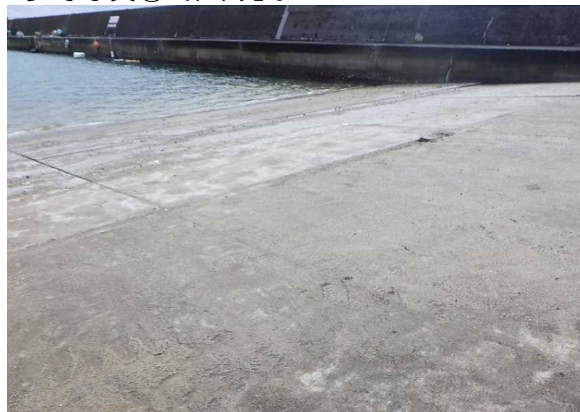
参考写真③: 作業完了
