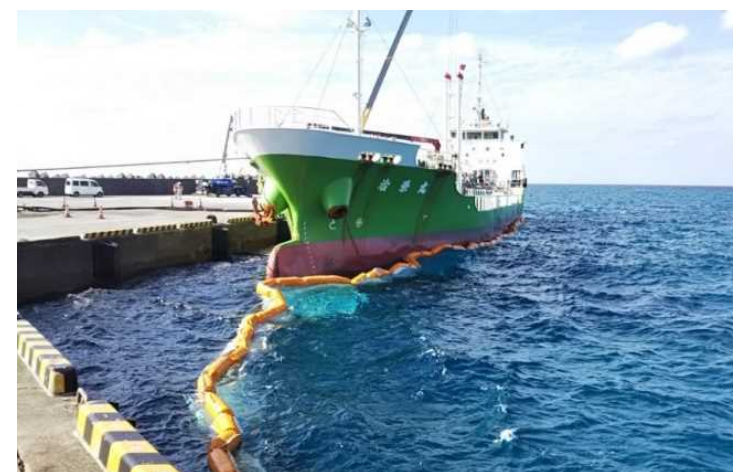
参考写真②: 汚濁防止膜展張状況
