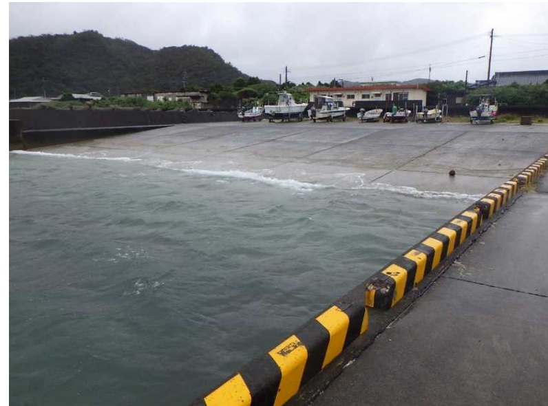
参考写真③: 作業完了
