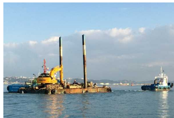
バックホウ台船 (曳船2隻体制で曳航) ※曳航時の留意事項はP7参照
