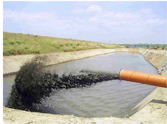
回収物排出状況
