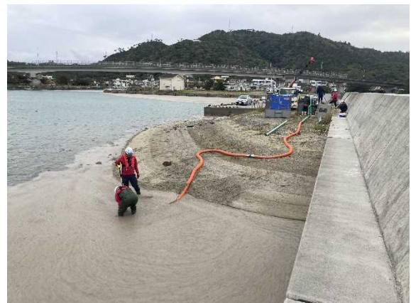
軽石吸水状況
