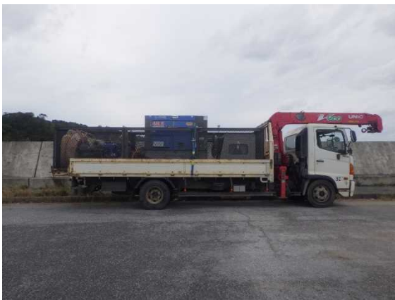
搬入資機材 4t ユニック車1台
