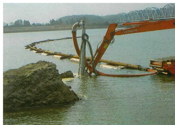
重機へ装着してのMJP浚渫状況
