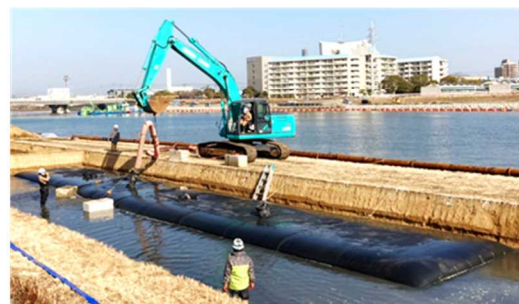
容量約 100\text{m}^3 の脱水ジオチューブ例 (長さ26m, 幅4.4m)
