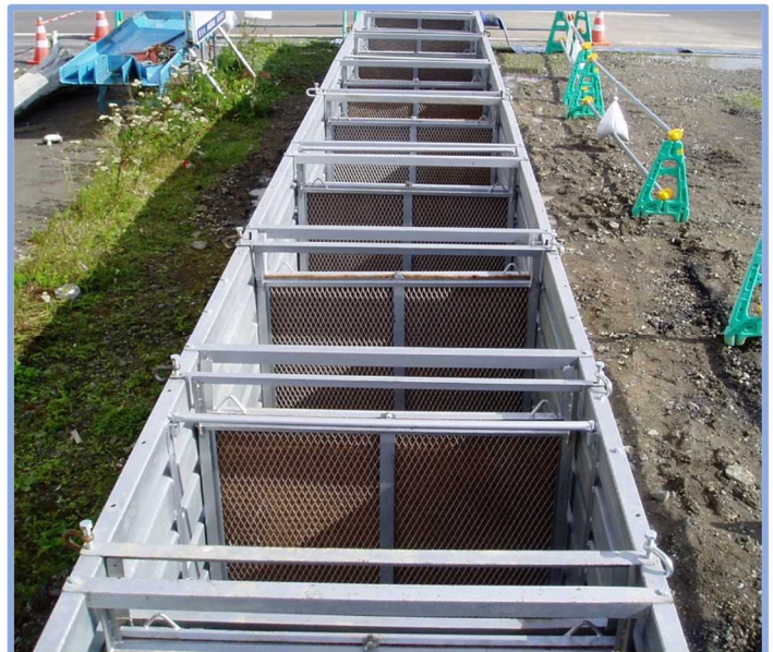
懸濁物質に合わせて、ヤシガラマットの数を自由に設定できます。
