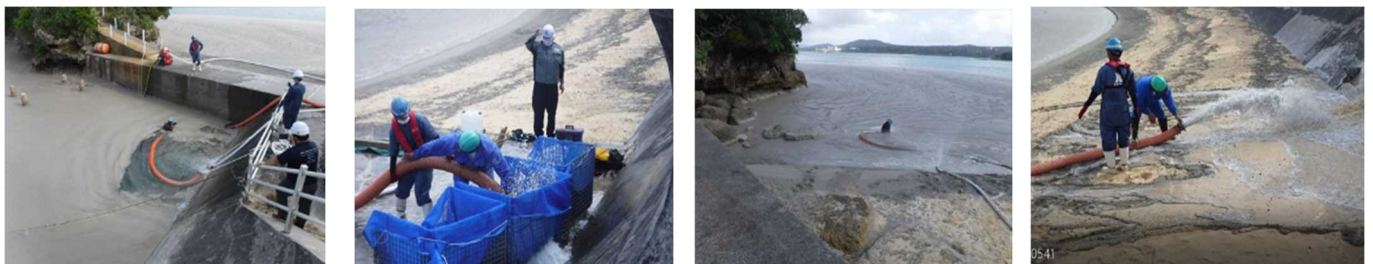
船溜まりの軽石の吸引(回収)と排出状況
