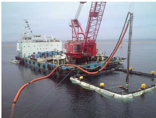
作業台船でのMJP浚渫状況
