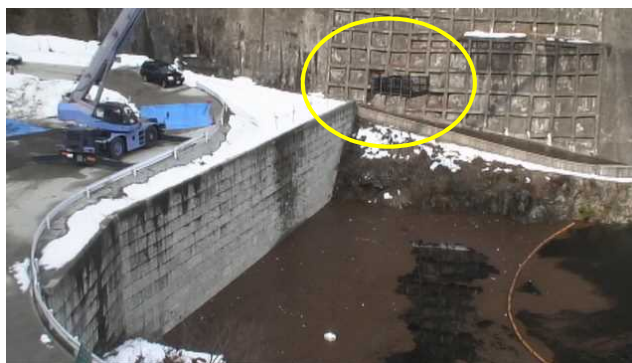
① クレーンで「回収カゴ：黄色○内」を操作し、人力作業無しで回収作業が行えます。
