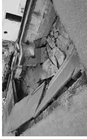
老朽化の進行による港湾施設の破損・事故例
