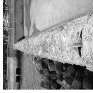
剥離・損傷
