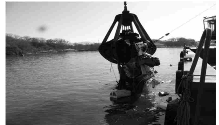
非常災害時の航路啓開 (東日本大震災時)
