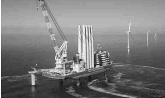
○ OSEP船*による海上施工の状況
