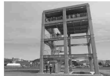
津波避難タワー(船川港)
