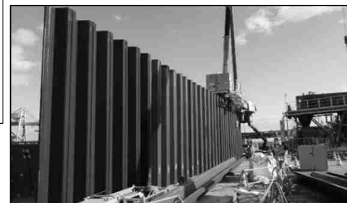
護岸の耐震・液状化対策 (大分港海岸)
