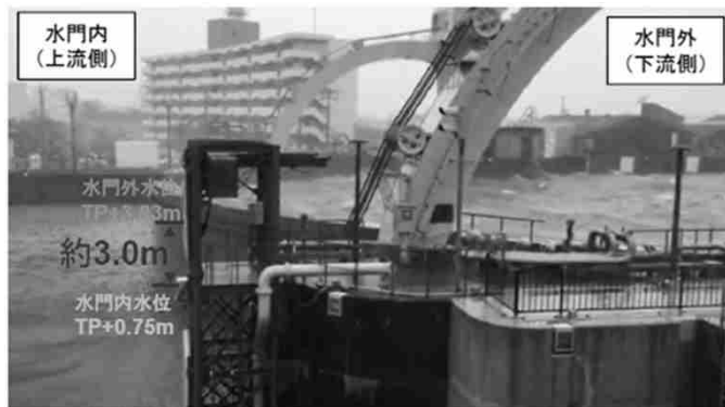
木津川水門（平成30年9月4日）
