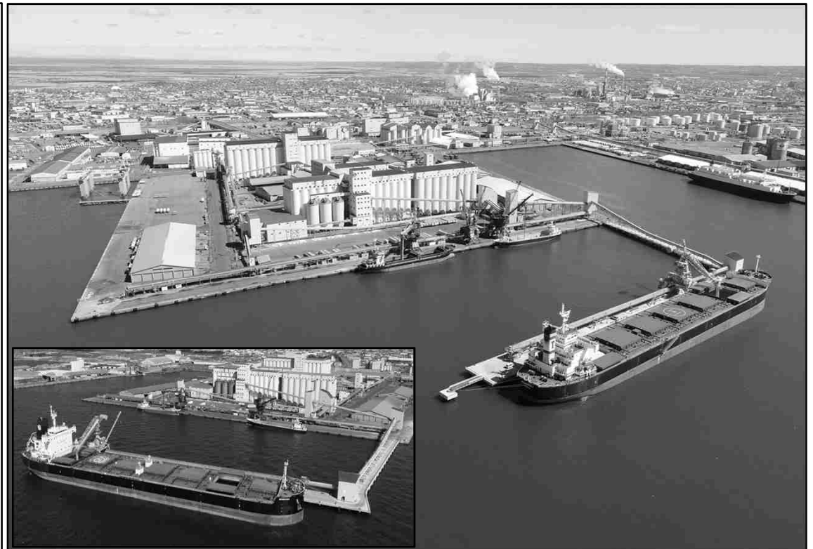
釧路港国際物流ターミナル(平成31年3月供用開始)
