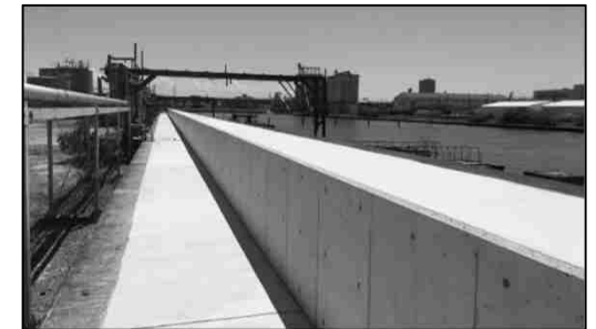
高潮から背後地域を守る護岸 (名古屋港海岸)
