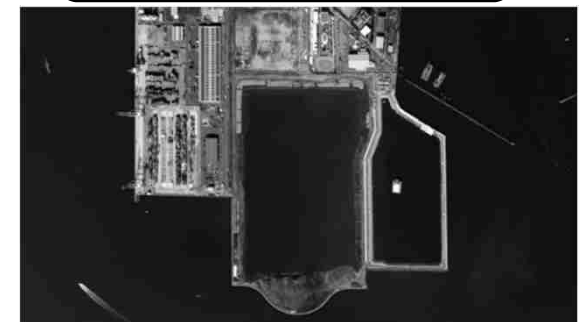
他地域の処理施設での中間処理及び海面処分場での災害廃棄物の受入れ
