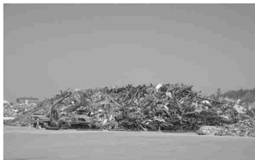
港湾での災害廃棄物の仮置き・分別
