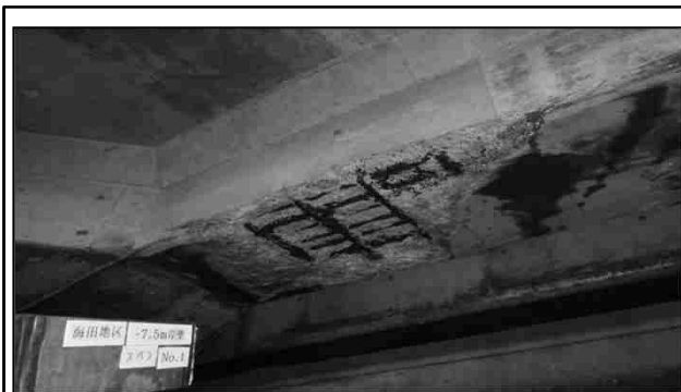
栈橋床版の老朽化が進行しているイメージ
