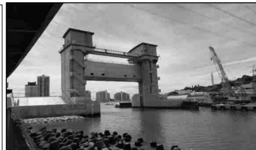
津波から市街地を防護する水門 (和歌山下津港海岸)
