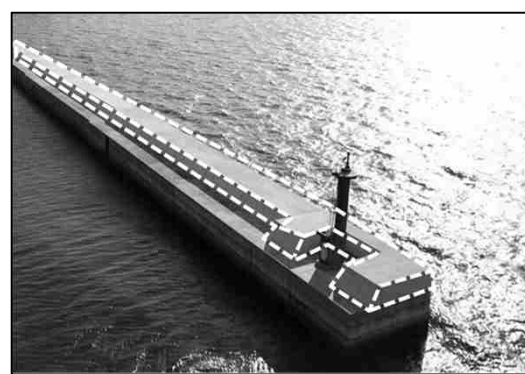
[防災・安全交付金] 津波対策として防波堤嵩上げ (湯浅広港)
