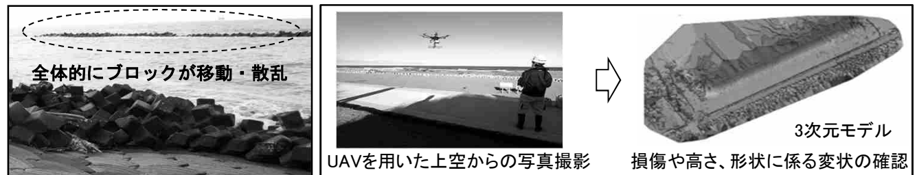
離岸堤の老朽化が進行しているイメージ
