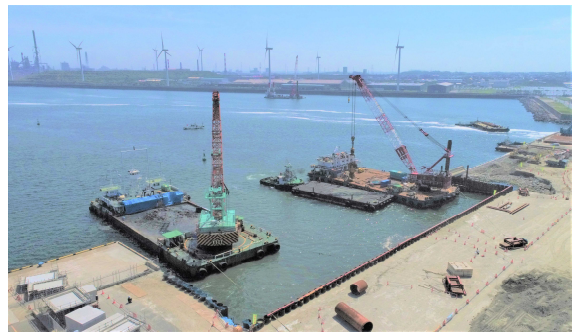
鹿島港外港地区 洋上風力発電基地港湾整備
