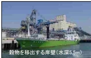
水島港 (岸壁の整備)
