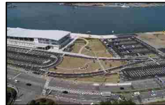
金沢港 (緑地・道路の整備)
