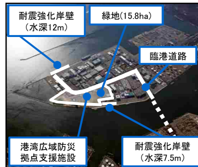
基幹的広域防災拠点(川崎港)
