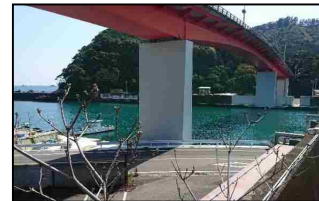
長島港 (橋梁の改良)
