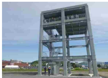
津波避難タワー(船川港)
