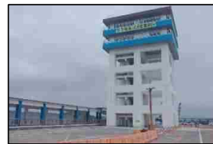
新島港 (津波避難施設の整備)
