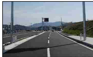
徳島小松島港 (臨港道路の整備)
