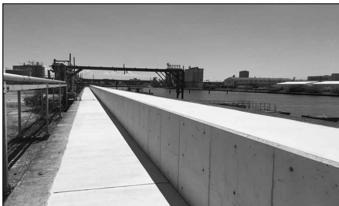
高潮から背後地域を守る護岸 (名古屋港海岸)
