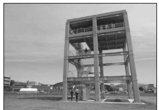
津波避難タワー (船川港)
