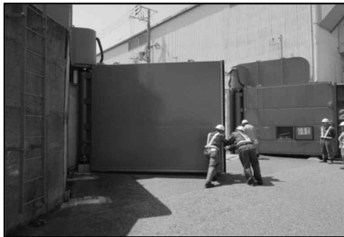
平常時の点検・訓練 （大阪港海岸）
