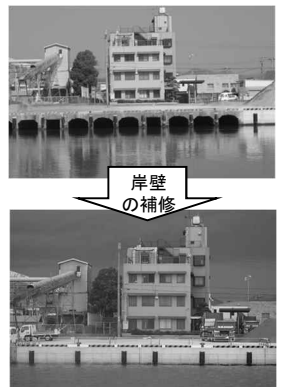
老朽化した岸壁の補修(東播磨港)
