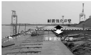
海上交通ネットワーク維持のための耐震強化岸壁の整備や臨港道路の耐震化等を実施
