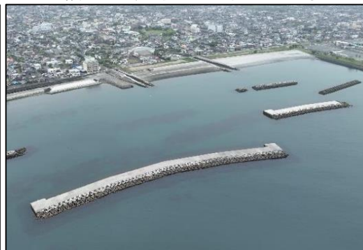
高波を減衰させる離岸堤 (指宿港海岸)
