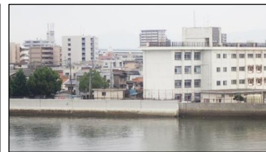
高潮等から市街地を防護する護岸 (広島港海岸)
