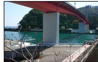
長島港 (橋梁の改良)
