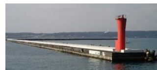
防波堤の粘り強い化(御前崎港)
