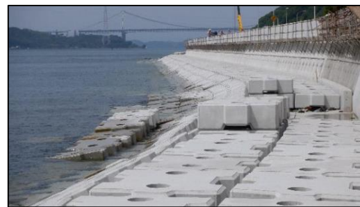
高潮等から市街地を防護する護岸 (下関港海岸)
