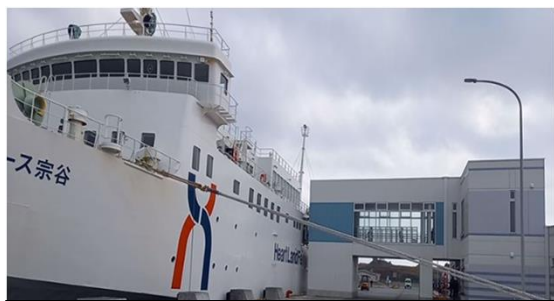
沓形港耐震岸壁・フェリーターミナル
