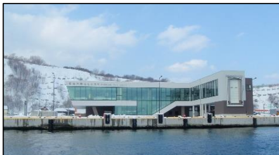
鴛泊港フェリーターミナル
