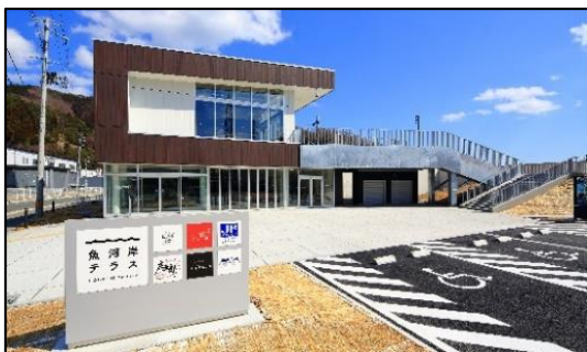
釜石魚河岸にぎわい館 「魚河岸テラス」
