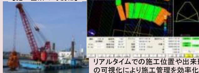
【施工箇所の可視化】
