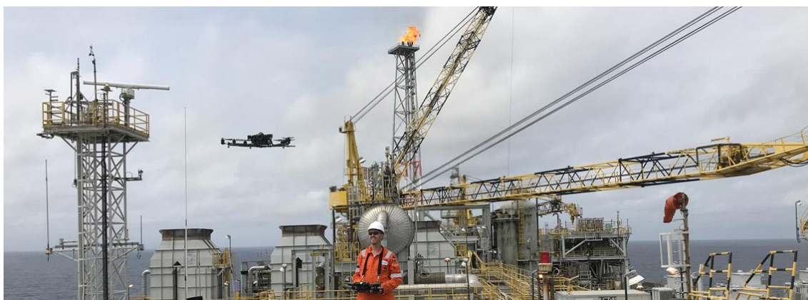
図 9-2-4 FPSO 設備検査におけるドローン利用
