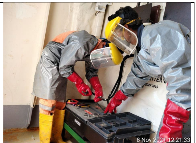
鉛酸バッテリー除去作業
