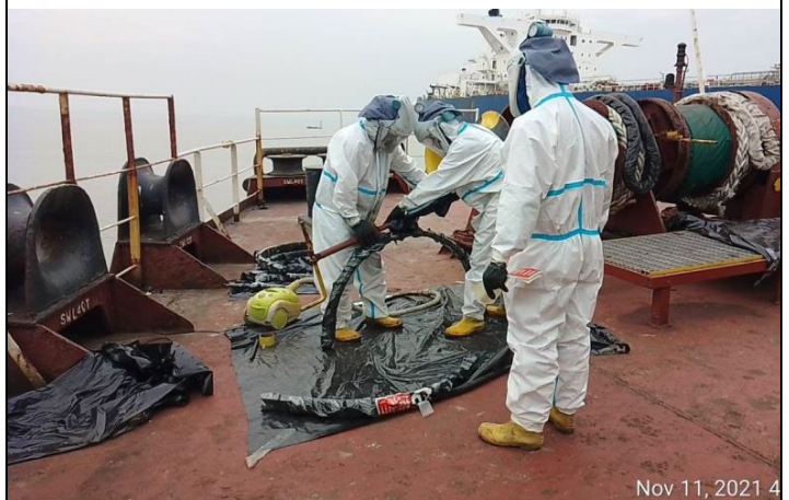
アスベスト汚染物資除去作業
