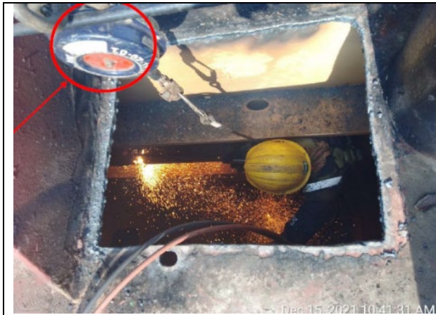
高所作業での落下防止ギア設置
