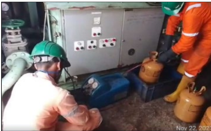
ODS 除去作業
