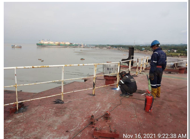
落下防止柵の設置 (高所作業)
