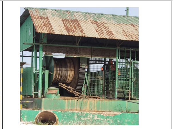
ヤードに設置されているウインチ
