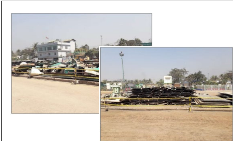
ストックヤードにおけるバリケードと積み高
