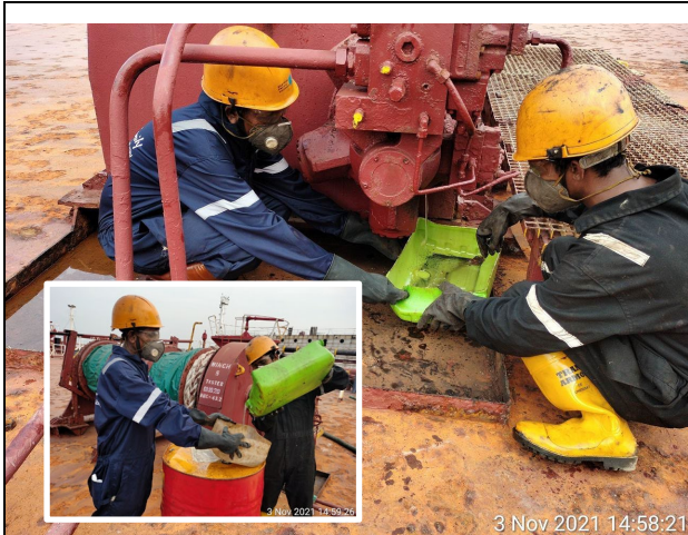
廃作業油除去作業
