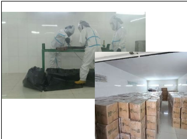
アスベスト固化処理のための密閉空間対応と処理後のアスベスト保管状況
