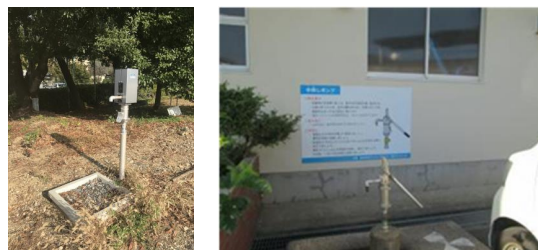
図 6.2-7 非常用井戸の外観
