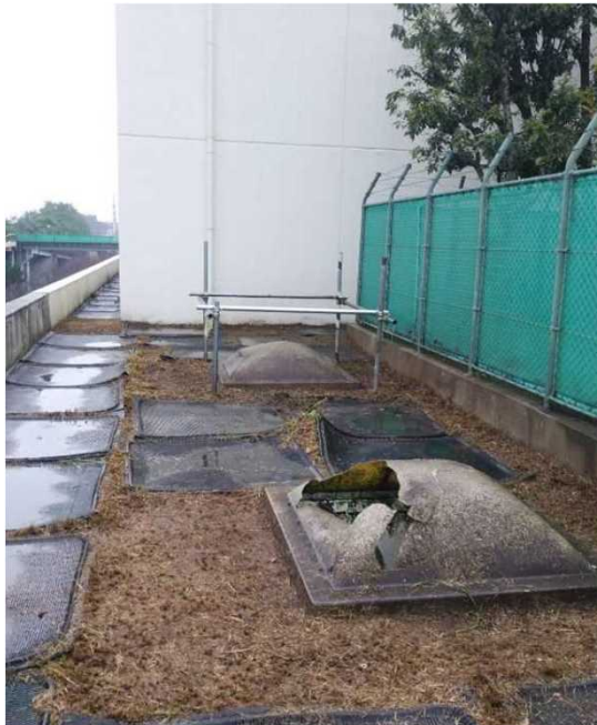
【事故状況写真】
