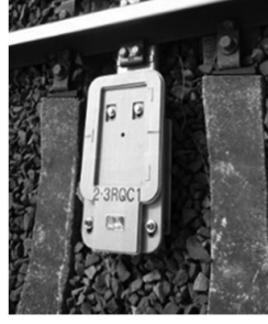
(軌道改良(PCまくら木化)) (自動列車停止装置(ATS))
