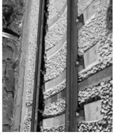
線路設備 (軌道改良(PCまくら木化))
