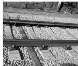
線路設備 (軌道改良(PCまくら木化))
