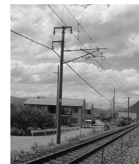
電路設備(電柱の更新)
