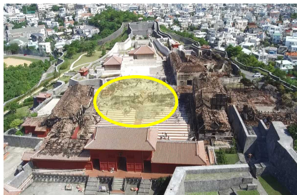
伝統的な技法で作られた瓦を取り出し ながら、がれき等を丁寧に搬出
