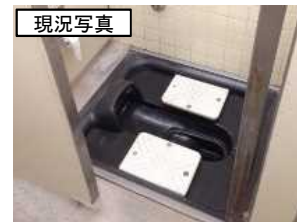
洋式便器に更新(4基)
