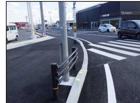
交差点改良 (歩道拡幅、歩行者溜まりの整備)
