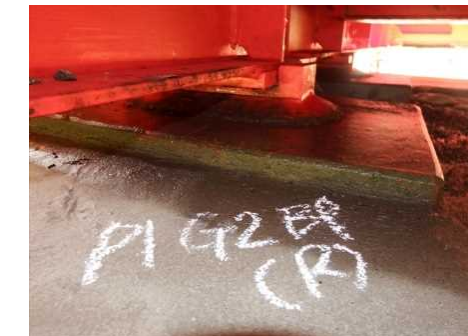
沓座モルタルの補修
