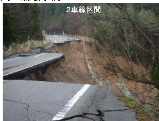
4車線／2車線区間の崩壊事例
