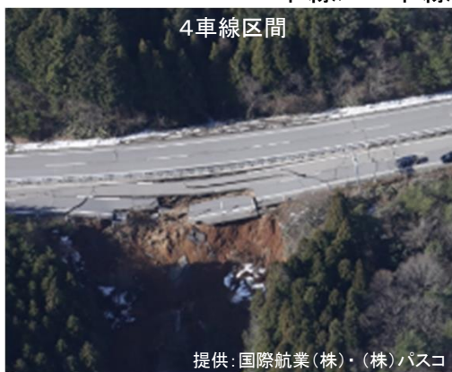
4車線／2車線区間の崩壊事例
