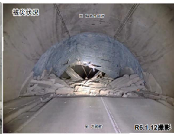
中屋トンネル(国道249号)
