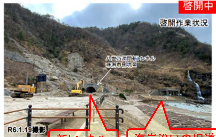
新トンネル 海岸沿いの旧道
