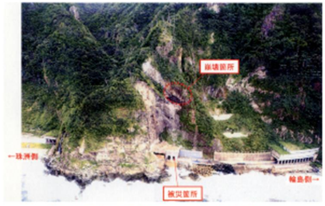
写真-7.3.25 被災箇所の被災前全景(復旧後調査資料より)
