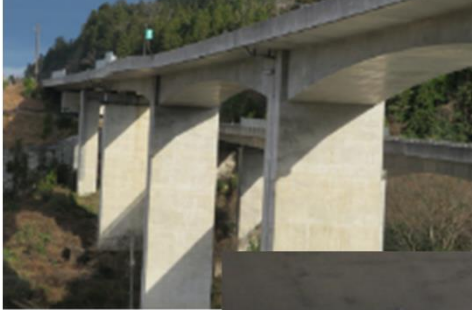
穴水道路 穴水高架橋(H14道示)
