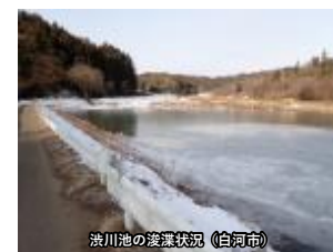
農業用ため池の治水整備
