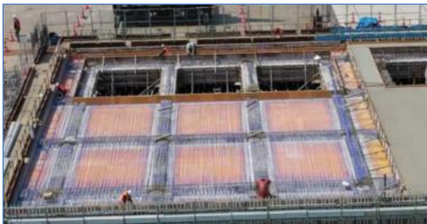
RC(鉄筋コンクリート)の現場での打設
