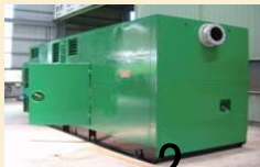
○非常用発電機
