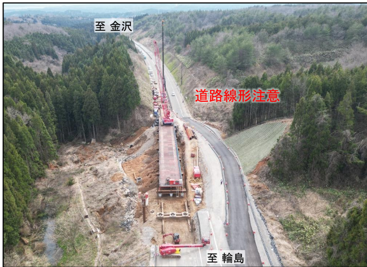
のと里山空港IC～穴水IC間 (穴水町北七海地先)
