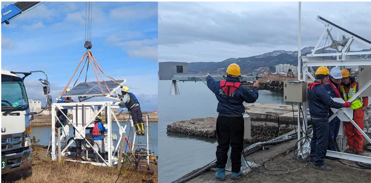
① 設置作業の様子(左:太陽電池パネルの取付け、右:電波式津波観測計の設置)
