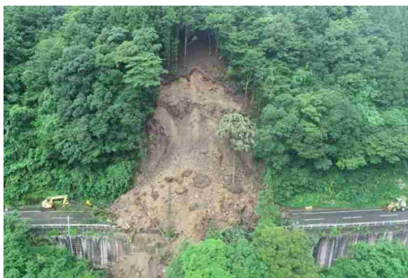
土砂崩落による通行止め
