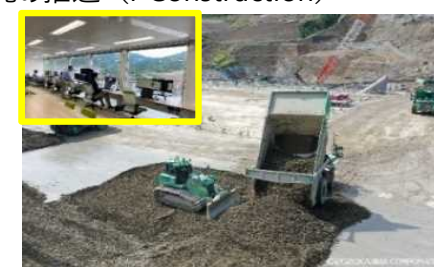
▲建設機械の自動運転
