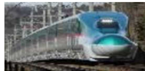
高速鉄道に関する調査、設計、工事管理等
