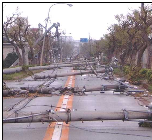
<電柱の倒壊による道路閉塞>
