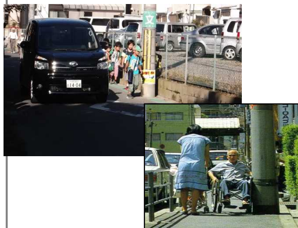
<歩行の支障となる電柱>
