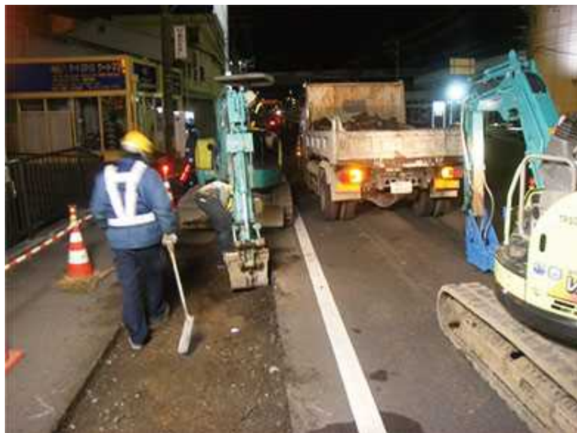
バックホウによる掘削作業とダンプトラックへの積み込み作業が並行作業となっている
