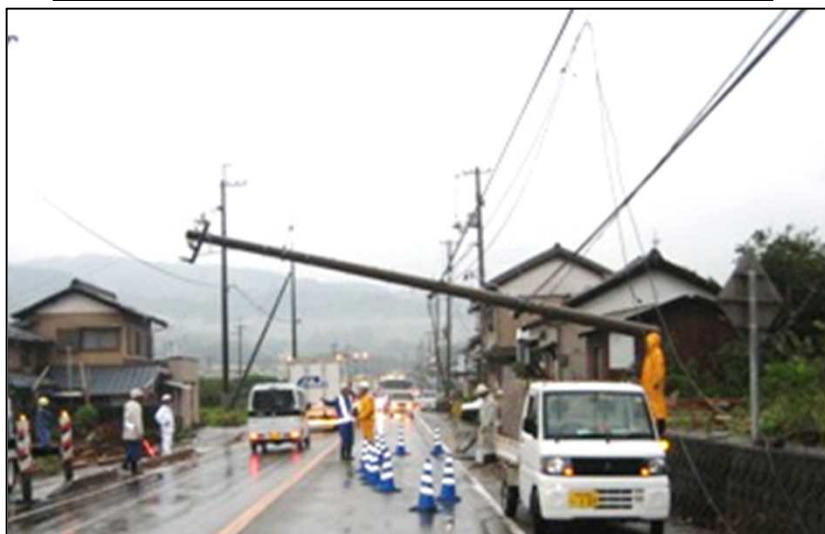
国道55号 高知県安芸市
