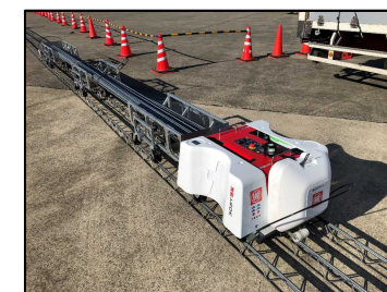
鉄筋運搬ロボット
