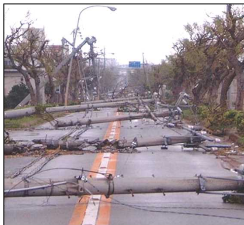
<電柱の倒壊による道路閉塞>
