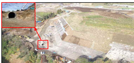
犀角山トンネル
