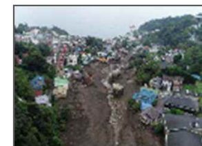
R3年7月豪雨による土砂災害
