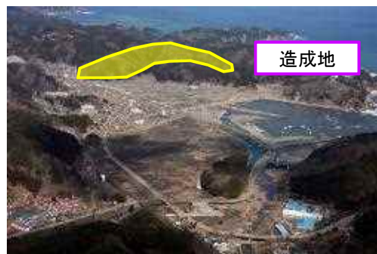
移転先造成地
