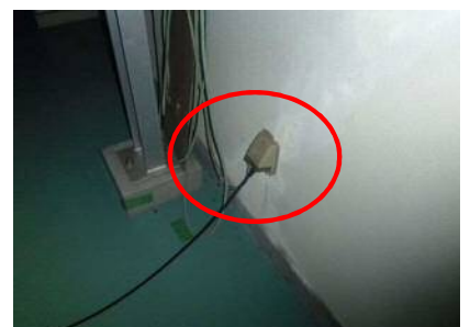
▼ 真鍋島(ゆきの浜処理場)の電源(100V×2口×2)
