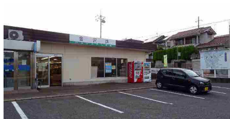
▲団地内の主な目的地(スーパーマーケット)
