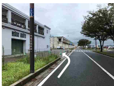
▲ 旧大連航路上屋車庫
