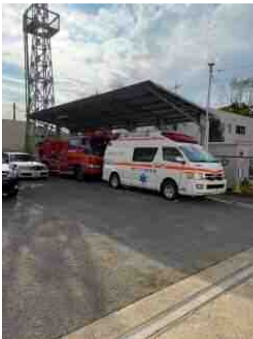
車庫現場写真
