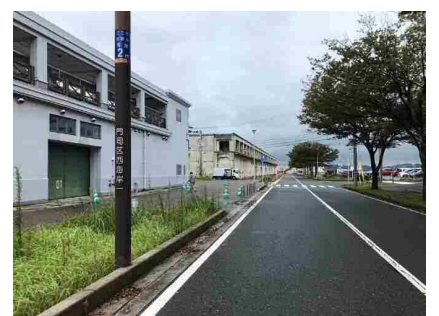
旧大連航路上屋 (車両保管場所)
