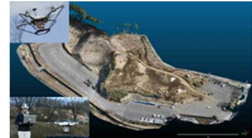
ドローンによる3次元測量 (国土地理院)
