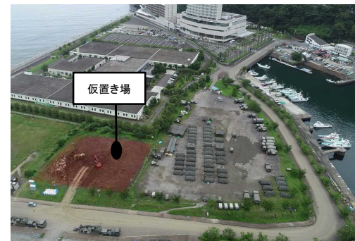
熱海港和田磯地区の調査状況 (仮置き場)
