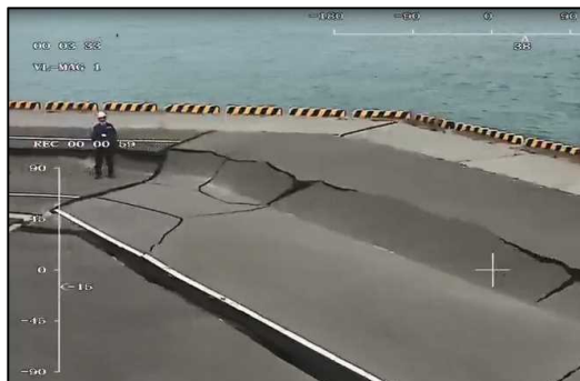
岸壁等の被災状況確認調査
