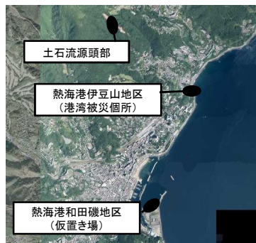
ドローン調査実施箇所
