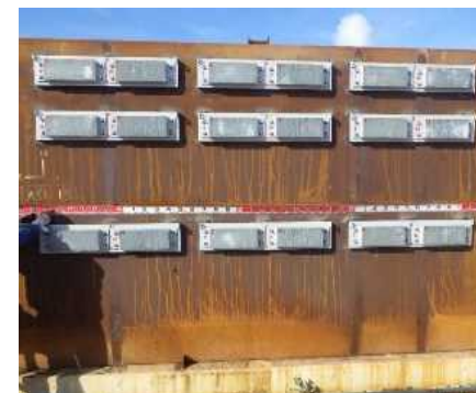
試験片の岸壁への設置
