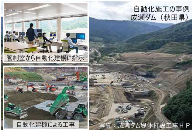
自動化建機による工事 ※ヒト・機械・資材・施工進捗データの見える化とこれを活用した施工改善にも取組む
