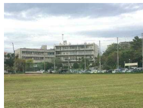
整備前の外観（北館）
