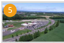
北海道音更町 音更町道の駅整備事業 [道の駅おとふけ 「なつぞらのふる里」]
