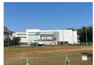
整備後の外観（北館）
