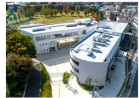
民間付帯施設（手前）と北館（奥）
