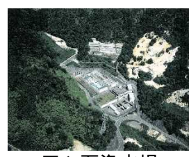
三ツ石浄水場 （西部地域用水）
