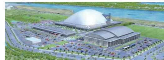
みつ市総合アリーナ (R2.9月供用開始、おおみなと臨海公園 一帯を広域避難場所として活用予定)
